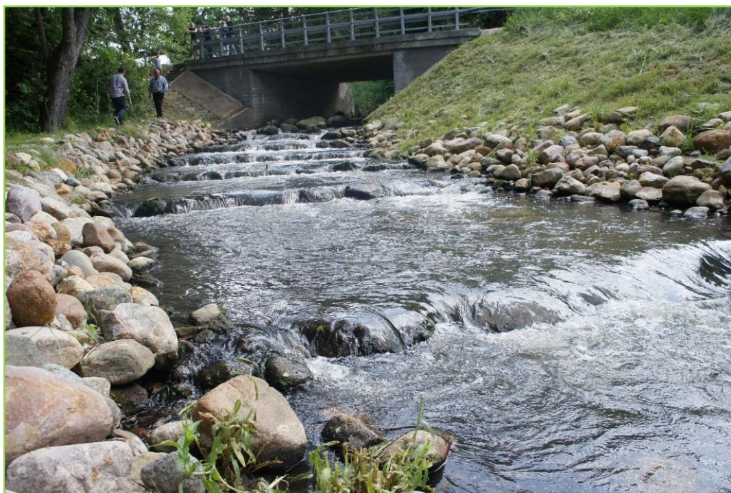
Stopień piętrzący w miejscowości Pomień na rzece Stobnica w km 2 + 630 – stan po realizacji przepławki
