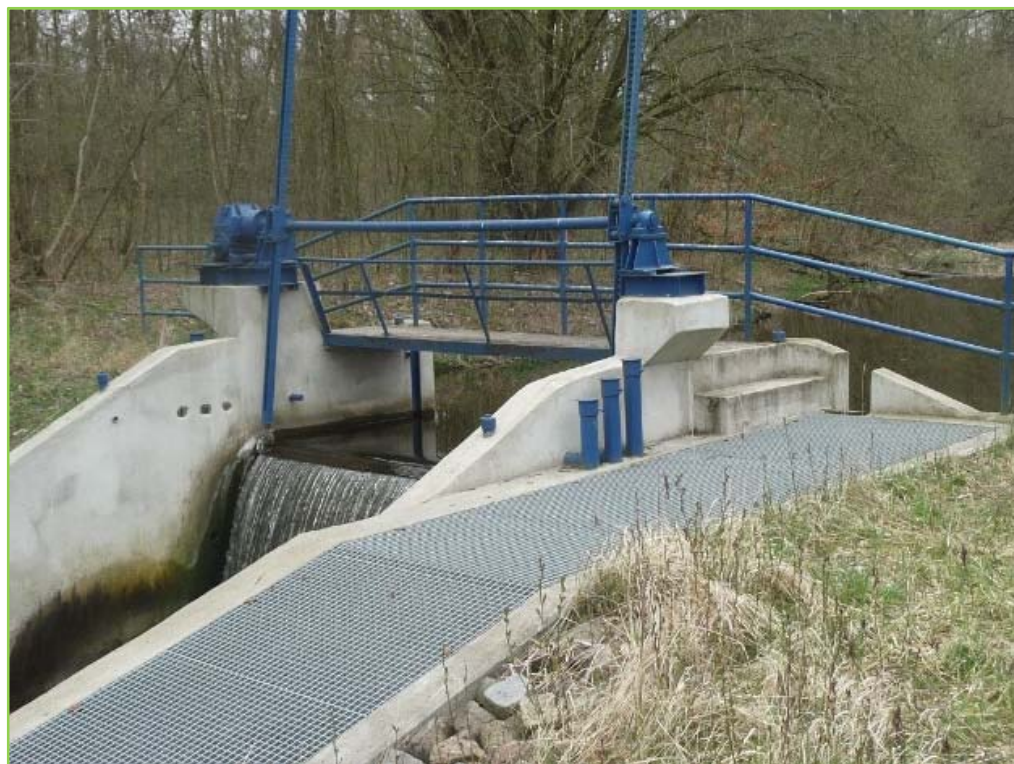
Jaz klapowy na rzece Krępa w km 1 + 100 – stan po realizacji przepławki
