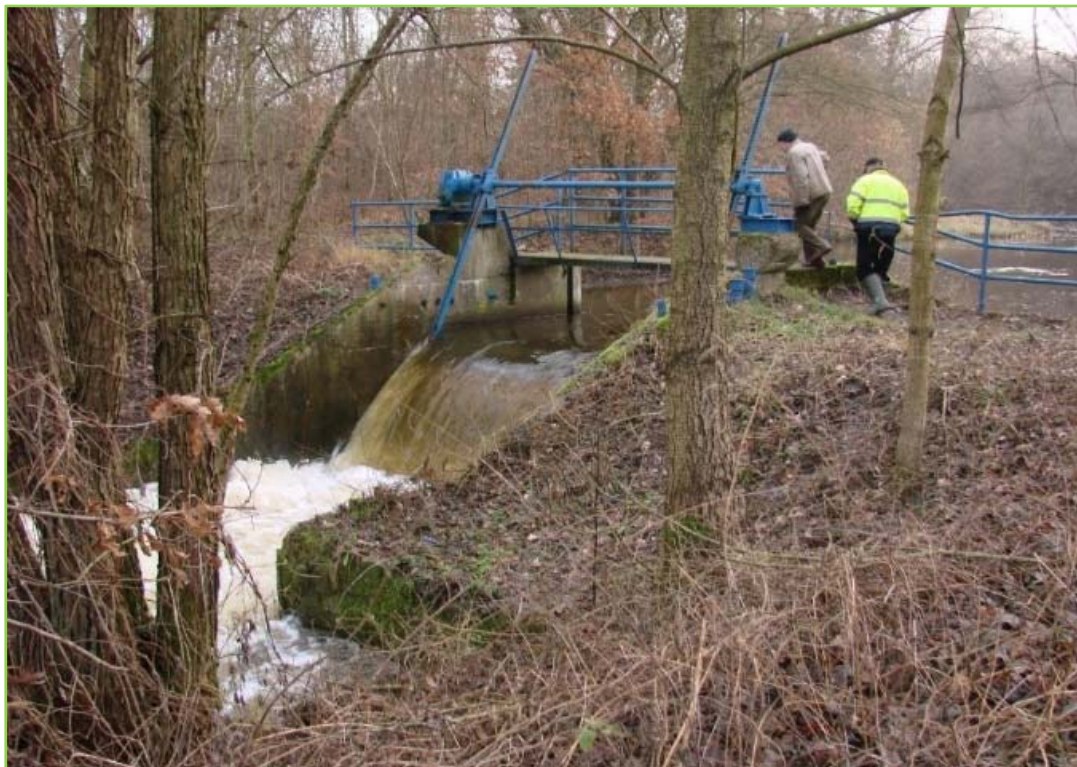
Jaz klapowy na rzece Krępa w km 1 + 100 – stan przed realizacją przepławki
