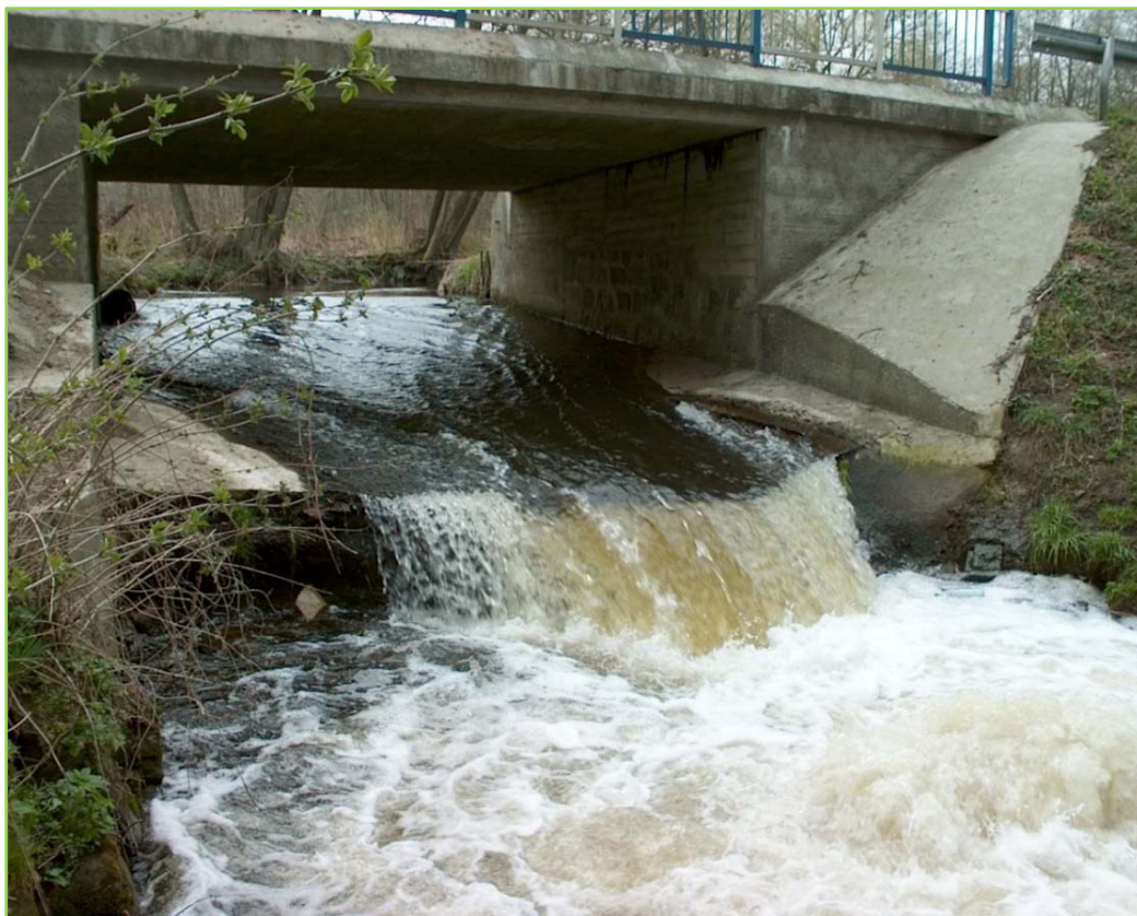
Stopień piętrzący w miejscowości Pomień na rzece Stobnica w km 2 + 630 – stan przed realizacją przepławki
