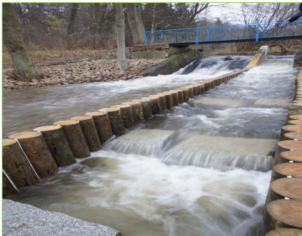
Jaz w miejscowości Reczyce na rzece Ina w km 104 + 370 – stan po realizacji przepławki
