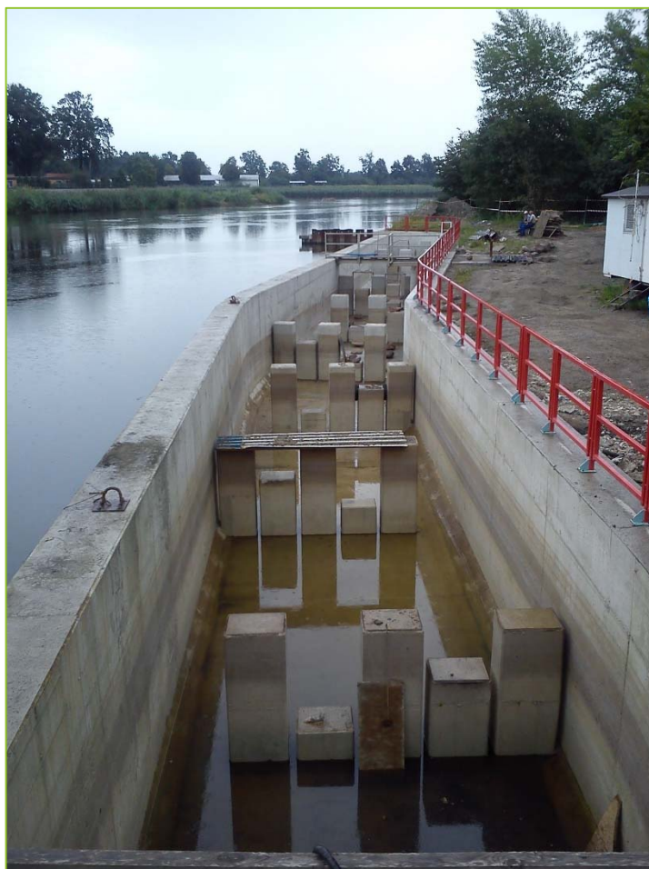
Przepławka przy jazie Opatowice w trakcie rozbudowy
