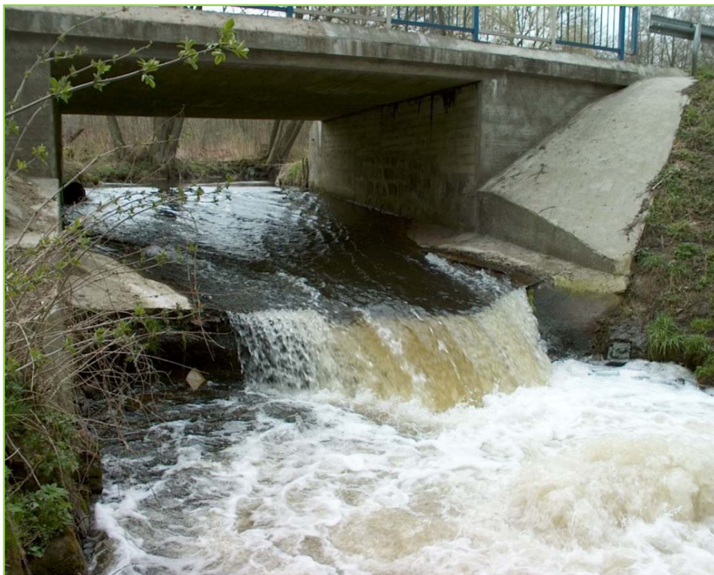
Vzdouvací stupeň ve vsi Pomieň na řece Stobnica, ř. km 2 + 630 – stav před stavbou rybího přechodu
