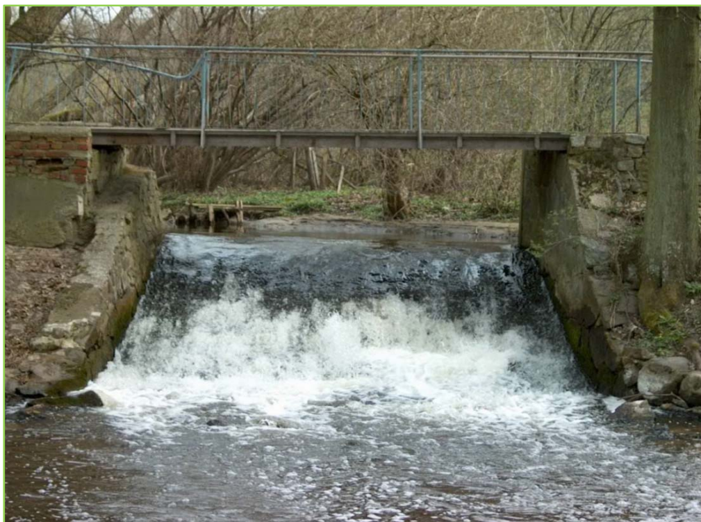
Jez ve vsi Reczyce na řece Ina, ř. km 104 + 370 – stav před stavbou rybiho přechodu
