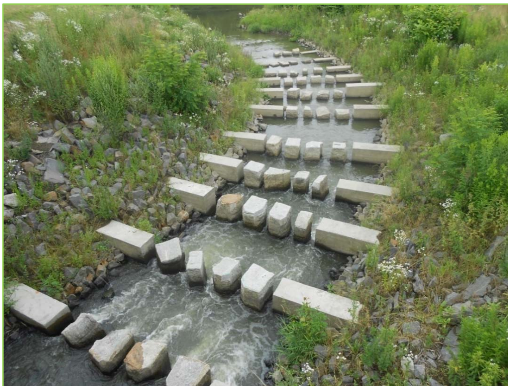
Zprůchodnění jezu Přívoz na řece Odře v Ostravě – vstupní část rybího přechodu
