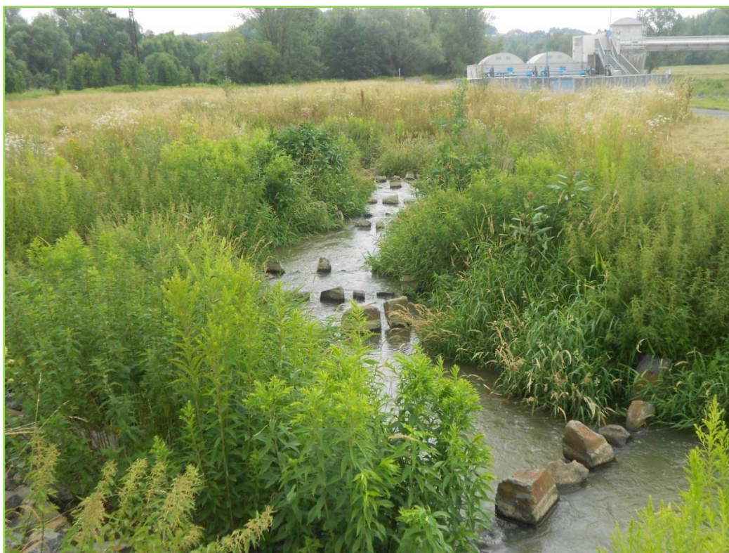
Rybí přechod na jezu Lhotka – horní část
