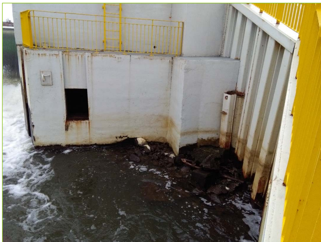
Rybí přechod Janowice – vstup do starého rybiho přechodu, v současné době slouží jako alternativní migrační cesta při vyšších vodních stavech
