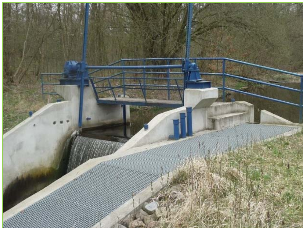
Klapkový jez na řece Křepa, ř. km 1 + 100 – stav po výstavbě rybího přechodu
