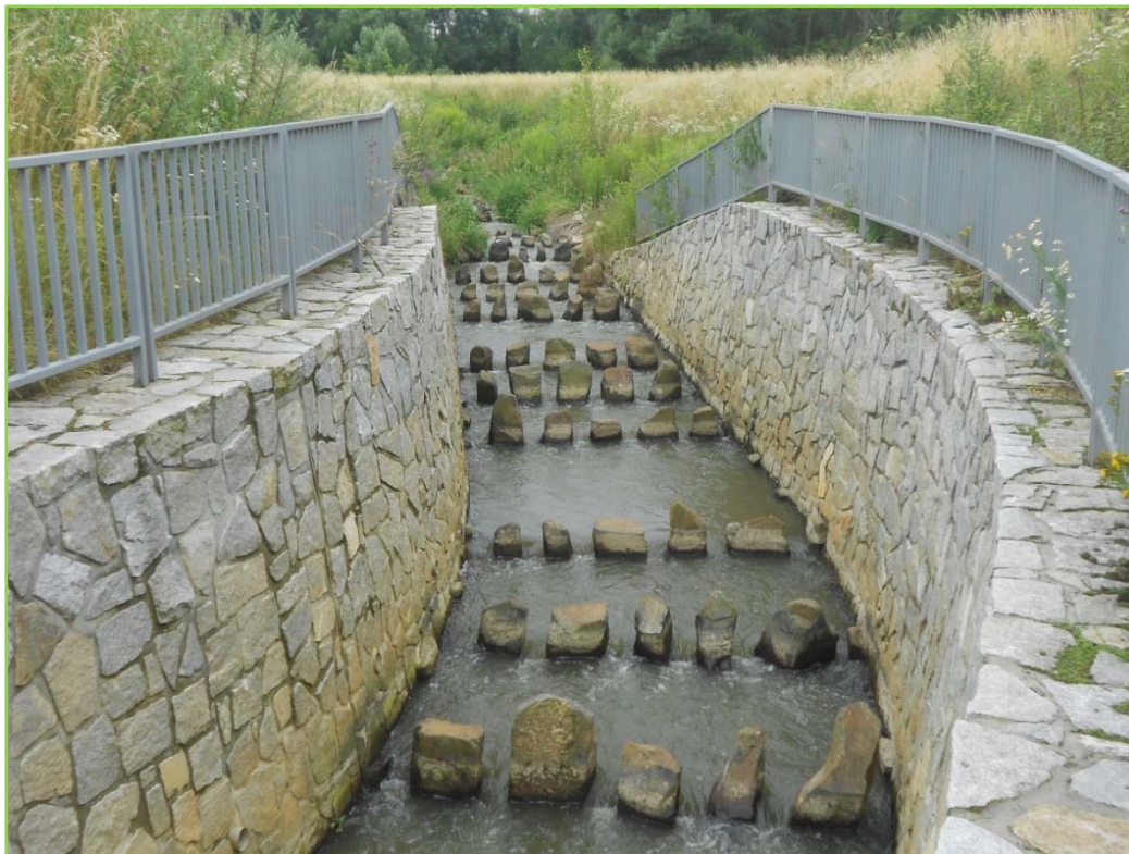
Rybí přechod na jezu Lhotka – dolní část
