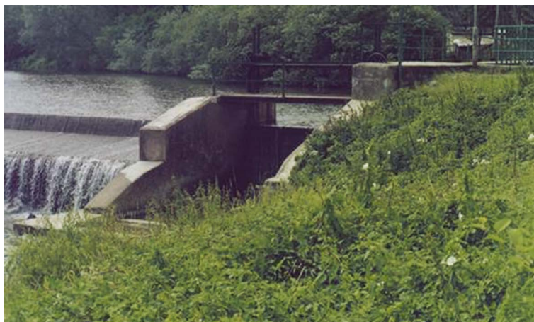
Stan przed realizacją
