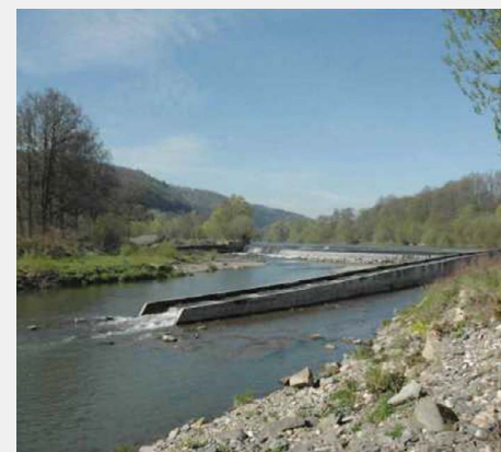
Stan po realizacji
