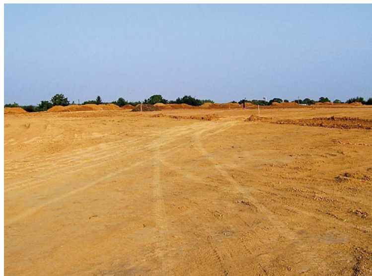
Warstwa słabo przepuszczalna (gliniasta) na składowisku odpadów komunalnych w Konradowie Źródło: Gminny Biuletyn Informacyjny Urzędu Miejskiego w Głucholazach, nr 13, 24.08.2012 http://www.glucholazy.pl/222/120102150000/Biuletyn-13-2012.pdf
