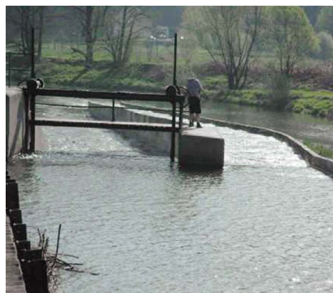
Stan po realizacji
