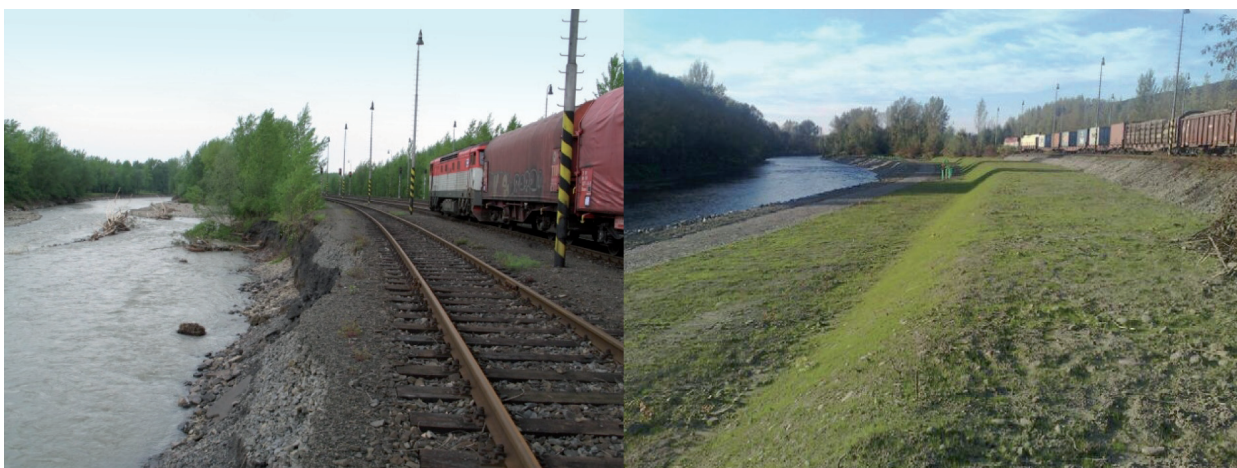
Rysunek 1: Oberwany brzeg rzeki Ostrawicy w Paskowie liczący ok. 600 m długości i ok. 40 m szerokości – bezpośrednio po powodzi w maju oraz po naprawie we wrześniu 2010 roku
