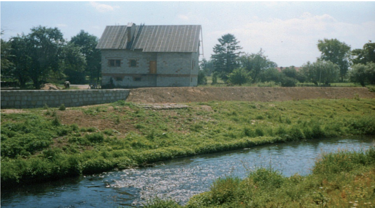
Zdjęcie 1: Murowany i ziemny wał przeciwpowodziowy chroniący zabudowania
