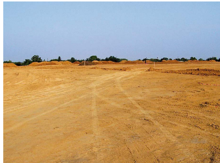
Schwach durchlässige (lehmige) Schicht auf der kommunalen Mülldeponie in Konradów
