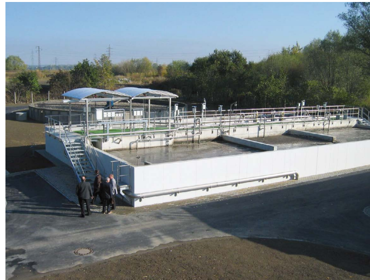
Parameter der Kläranlage: Q_{24} 8 500 m 3 /Tag; Q_p 11 000 m 3 /Tag; BSB 5 1740kg/Tag; EW 29 000. Projektant: Hydroprojekt CZ a.s., OZ Ostrava
