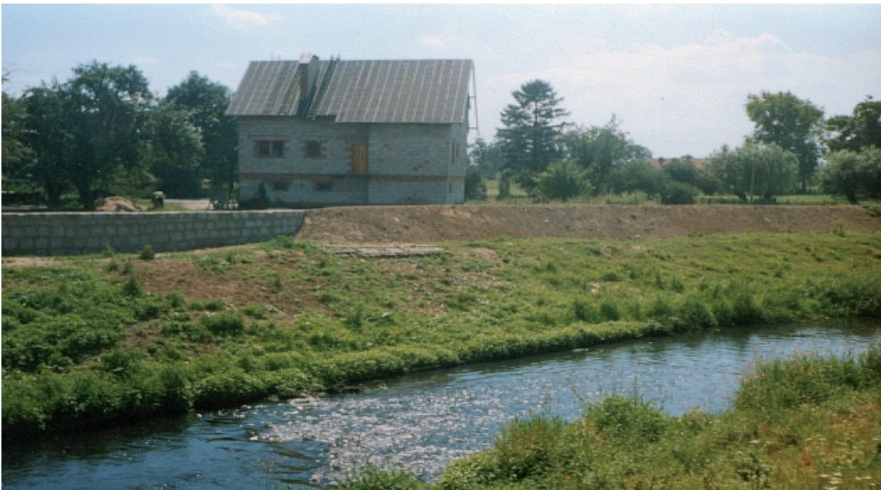
Foto 1: Mauer- und Erddamm zum Schutz der Bebauung vor Hochwasser
