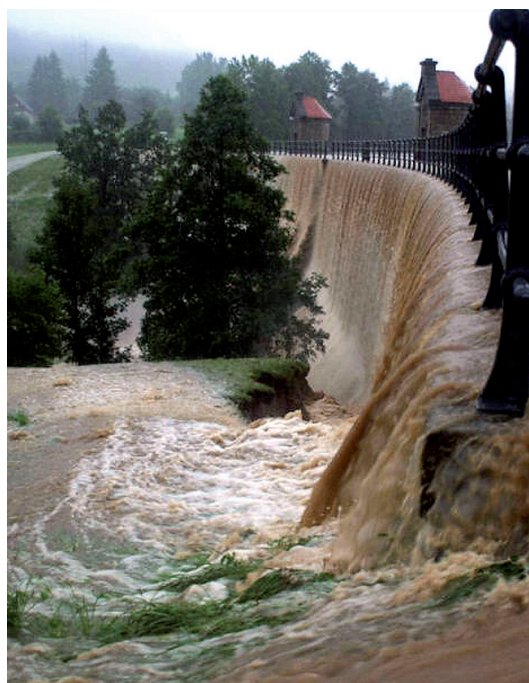
Abb. 1: Hochwasser 2010 auf dem Becken Mlýnice (1906) im Einzugsgebiet der Lausitzer Neiße überschritt deutlich Hochwasserereignisse mit einer 100-jährlichen Wiederkehr
