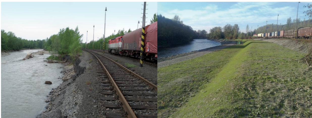
Obr. 1: Břehová nádrž řeky Ostravice v Paskově délky cca 600 m a šířky cca 40 m bezprostředně po povodni v květnu a opravená v září 2010
