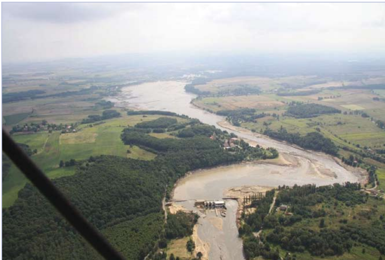
Obr. 15: Zničená hráz nádrže Niedów (Witka) a údolí Witky dne 8.8.2010 (Foto: SMI)
