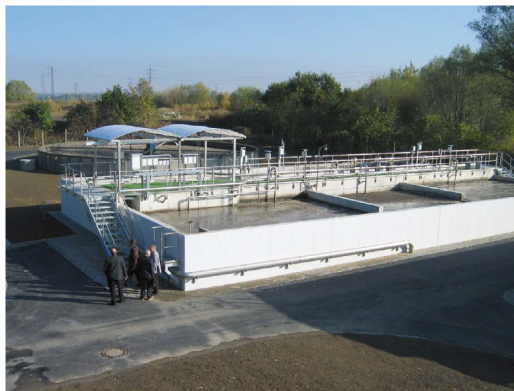
Parametry ČOV: Q_{24} 8 500 m 3 /den; Q_p 11 000 m 3 /den; BSK 5 1740 kg/den; EO 29 000. Projektant: Hydroprojekt CZ a.s., OZ Ostrava
