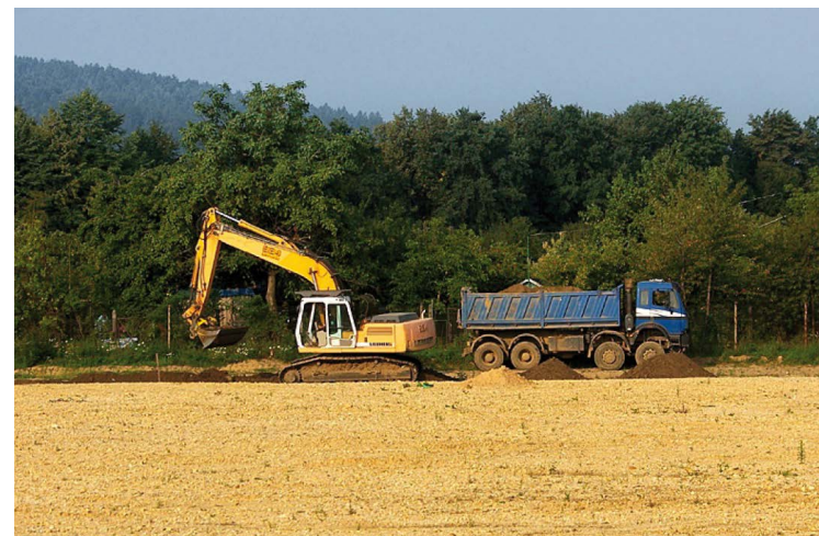
Tvorba propustné vrstvy (štěrkopísek) na skládce komunálního odpadu
